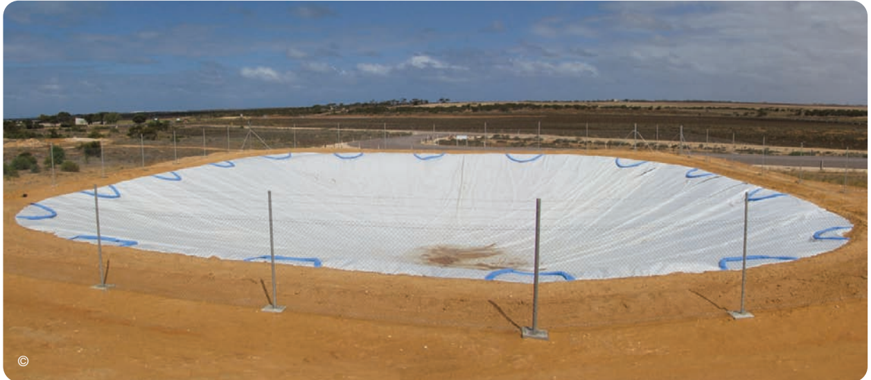
Instalación de VapourGuard por Fabtech SA Pty Ltd en Arno Bay, Sur de Australia (1.800m 2 )
