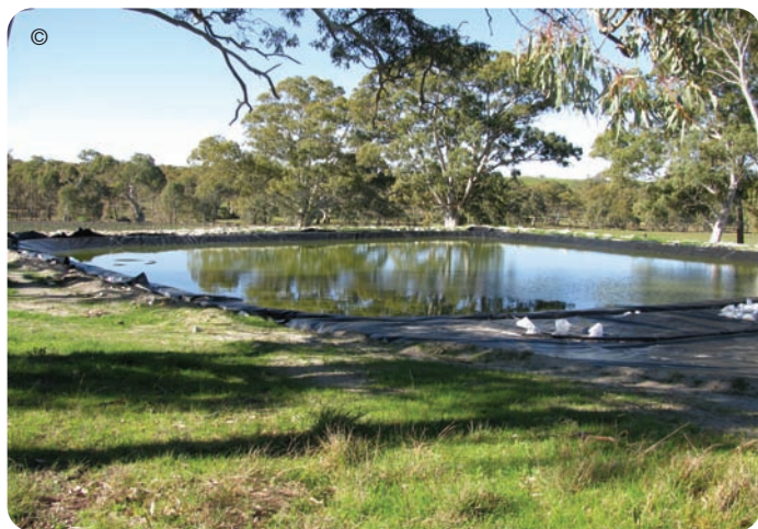
Presa antes de la instalación de la cubierta
