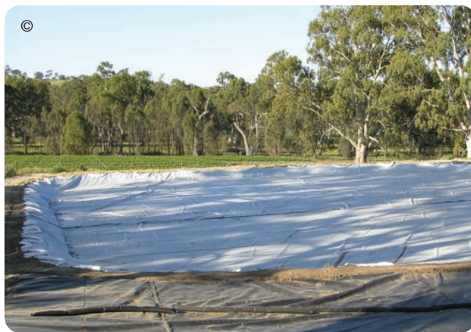
Couverture VapourGuard installée par Fabtech
